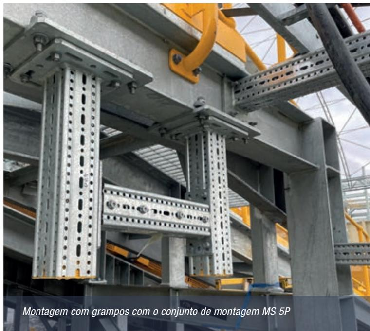
Montagem com grampos com o conjunto de montagem MS 5P
