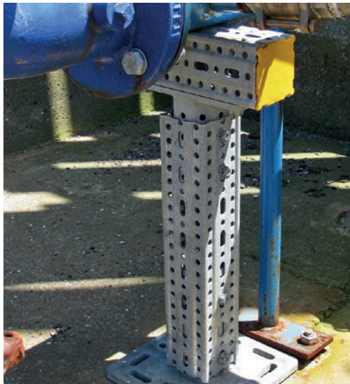
T-Supports konventionell und siFramo 80 wenige Monate nach der Montage
