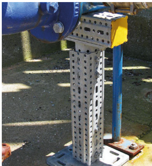
Suportes em T convencionais e siFramo 80 Alguns meses após instalação
